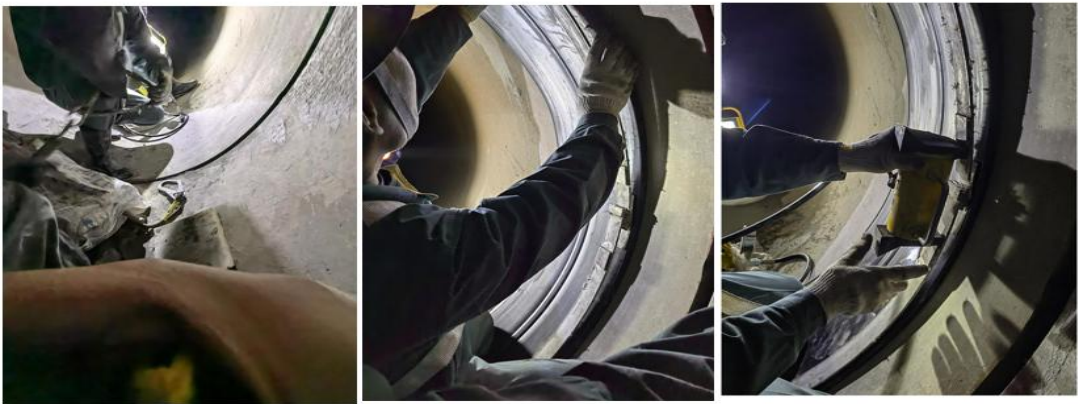
管道内壁修整，张紧钢条等工作
